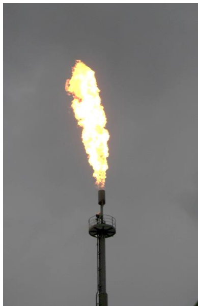
... und in Betrieb
