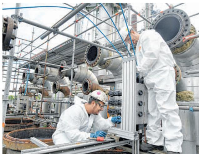
Eingemessen und genau positioniert wird der Rahmenaufsatz für die Hochdruckschläuche. Die Einstellung wird gespeichert. Das System wird Rechner-gesteuert.
