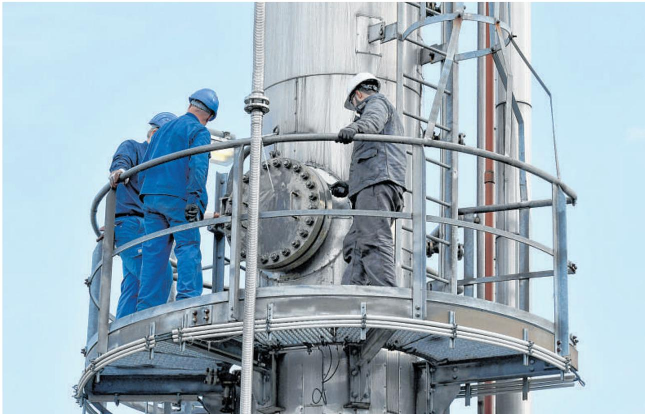
Hoch oben auf den Kolonnen prüft der TÜV Wandstärken, Dichtungen und Technik im Zuge der Revisionsarbeiten.
